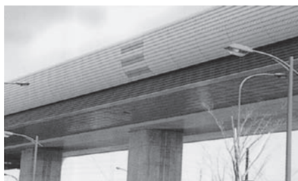
写真2 高架道路裏面
