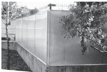
写真3 教育施設防音塀
