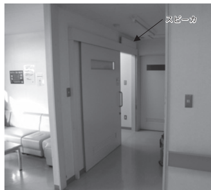
写真2 説明室扉および通路
