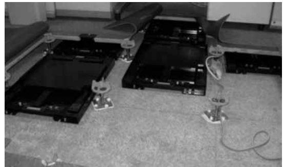
写真2 OAフロア下へのフロアメイト施工例
