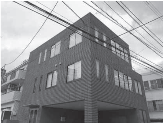
株式会社藤工様 新本社ビル外観
