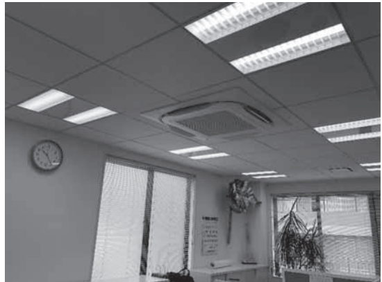
事務所執務スペース
